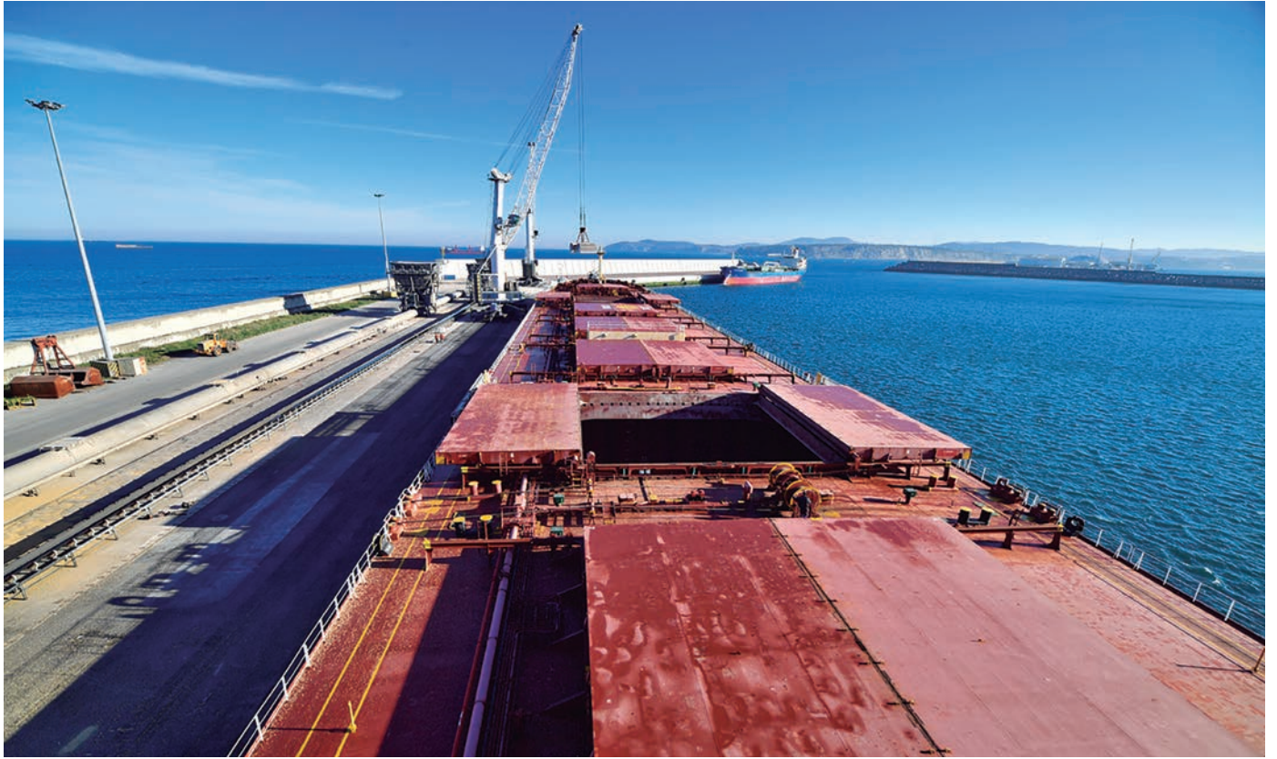
Las instalaciones que SLP opera en concesión en el Puerto de Bilbao disponen de una línea de atraque de 1,7 kilómetros de longitud con calados de hasta 20 metros.
