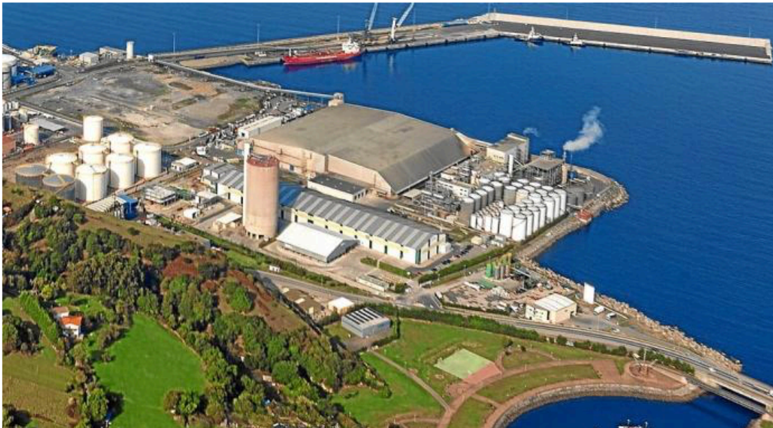
El muelle se habilitará en la línea de tierra al lado de los depósitos blancos y la chimenea. Foto: A. P. B.
