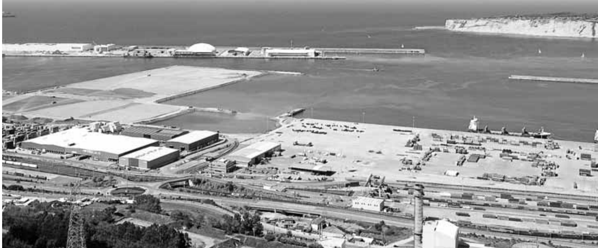
La nueva superficie ganada al mar ocupa ya el espacio central de la dársena portuaria y es la primera fase del espigón con el que terminará de crecer el puerto. Foto: Pablo Viñas
