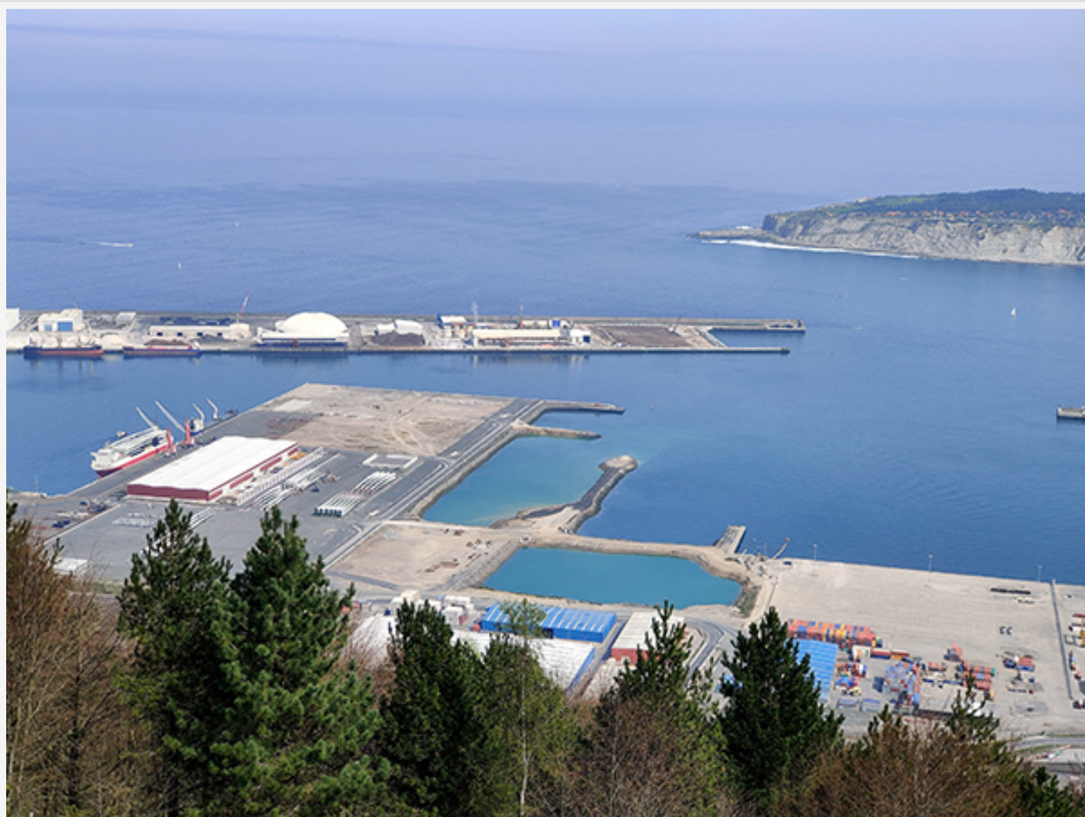
Vista aérea de la primera fase del Espigón Central del puerto de Bilbao, donde Toro y Betolaza ha logrado una autorización temporal para ocupar 16.000 m2.
