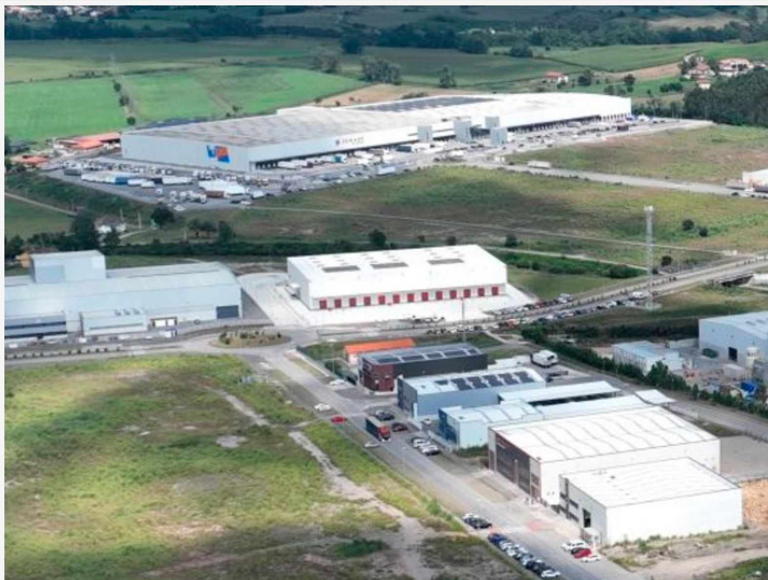
En la parte central de la imagen las nuevas instalaciones en Cantabria de Carreras Grupo Logístico, que tiene 13 muelles de carga y descarga en su fachada principal.
